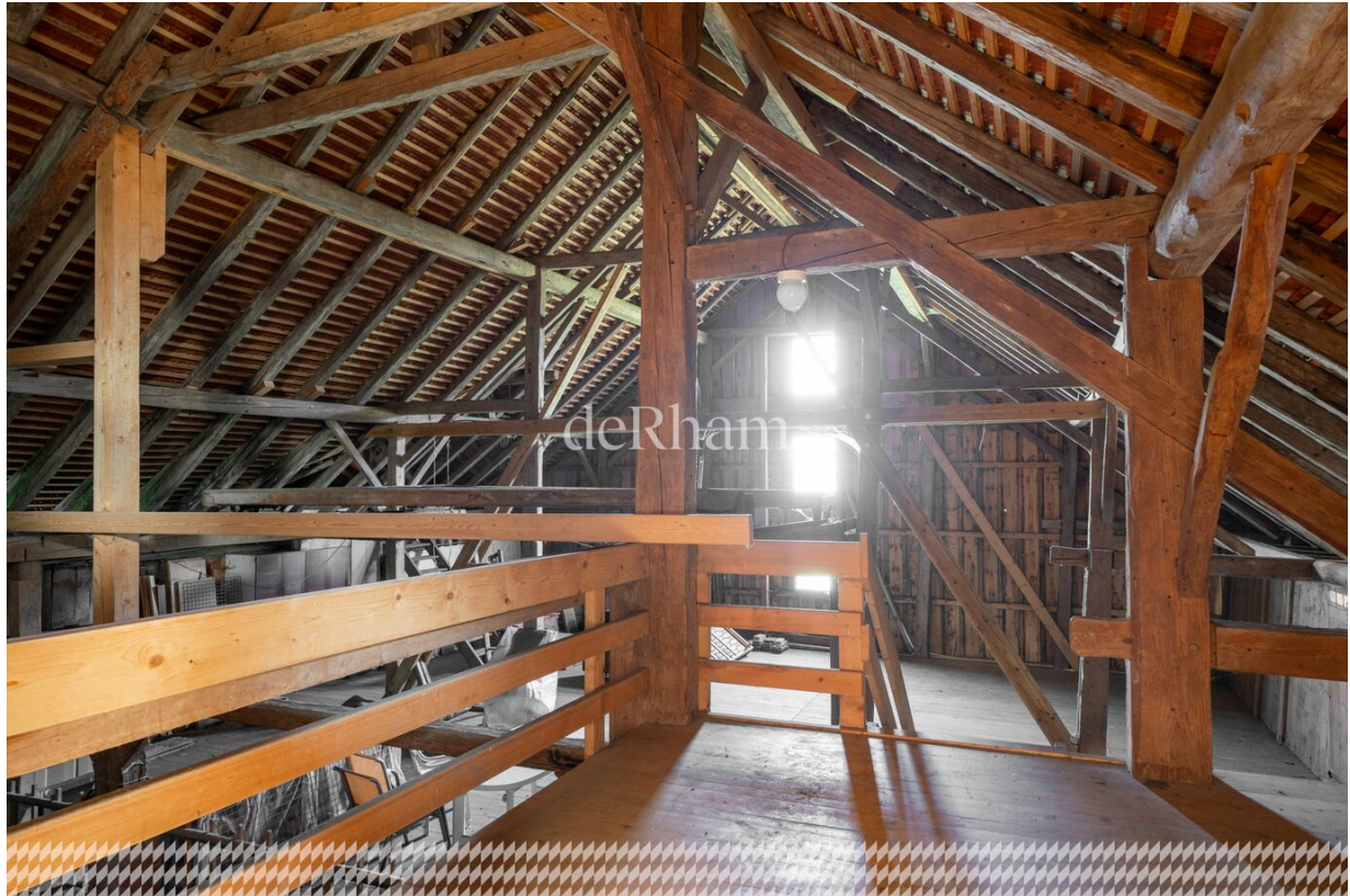
Charpente de la grange
